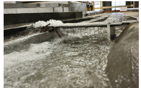
Blick in Fliessrichtung zur bestehenden Brücke unterhalb der Kraftwerkszentrale. Zu sehen ist eine vollständige Verklauung an der Brücke im Bereich der Geschieberinne und die damit verbundene Ausuferung.
