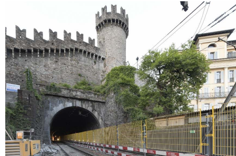
Bahntunnel Svitto mit Burg (Quelle: D. Lupini)
