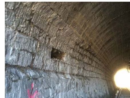
Gewölbe (Quelle: F. Preisig AG)
