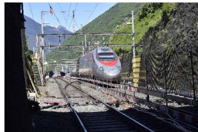
Stützmauern (Quelle: D. Lupini)
