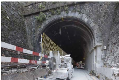
Portal Svitto-Tunnel (Quelle: D. Lupini)
